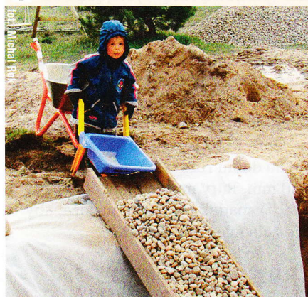
↑ Część prac inwestorzy przeprowadzili sami...
