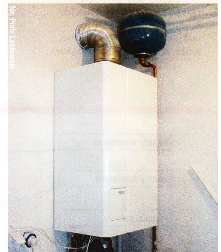
↑ Ciepło do ogrzewania domu dostarcza kocioł na gaz ziemny – paliwo stosunkowo tanie
