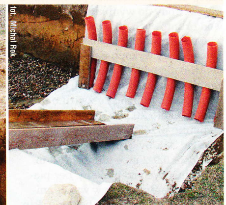
↑ Powietrze będzie dostarczane do złoża żwirowego plastikowymi rurami drenarskimi
