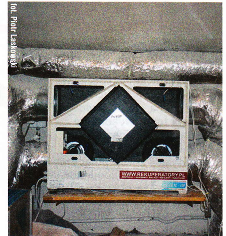
↑ Zimą rekuperator umożliwia odzyskiwanie z powietrza wywiewanego z domu 60-75% ciepła
