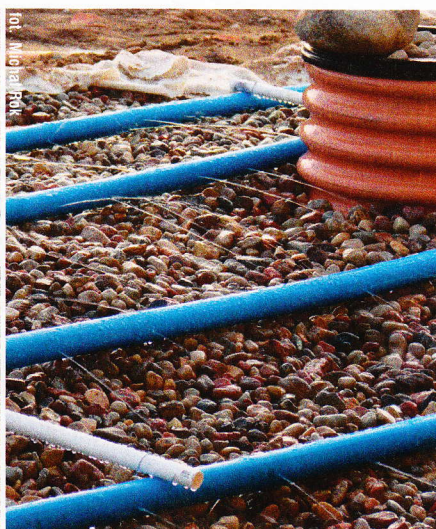
↑ Instalacja zraszająca ma przyspieszać regenerację złoża. W lecie powinna się przyczynić do większego schłodzenia powietrza
