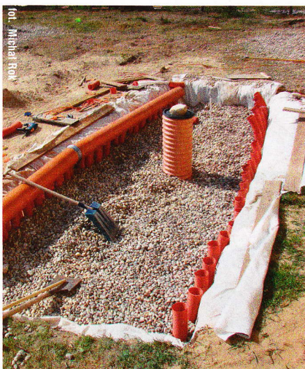
↑ Wypełnianie wykopu żwiru zajęło kilka dni – każda porcja była dokładnie przepłukana, by nie rozwinęły się w nim bakterie
